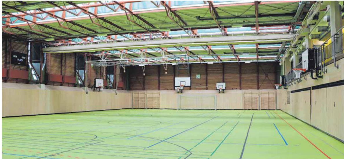
Blick in die Sporthalle der Geschwister-Scholl-Schule nach der umfassenden Teilsanierung.
